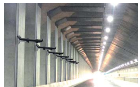
Installation des PEC Kabelhaltersystems im Tunnel
