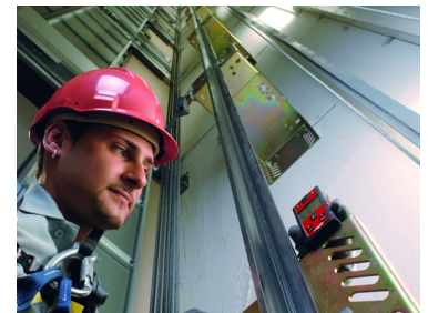
PEC Ankerschienen sind zum Einbau von Aufzügen hervorragend geeignet.
