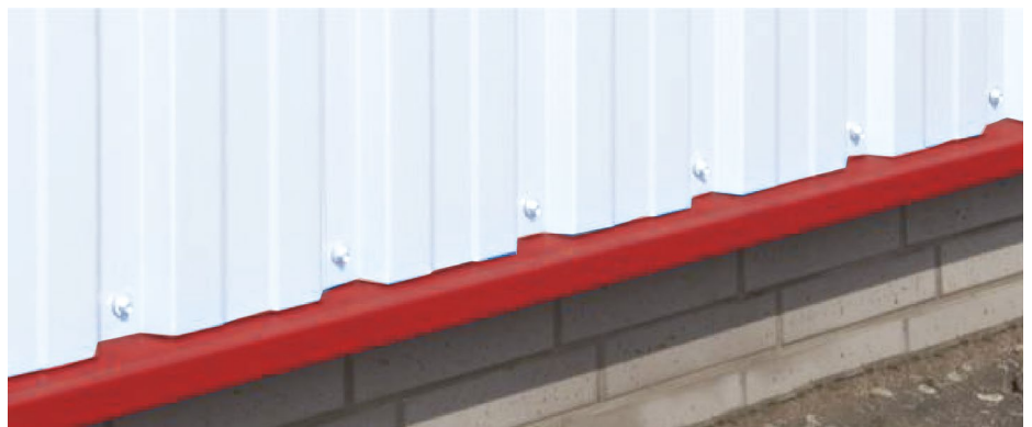
Beispiele für die Befestigung von Trapezblechen mit PEC-TU
